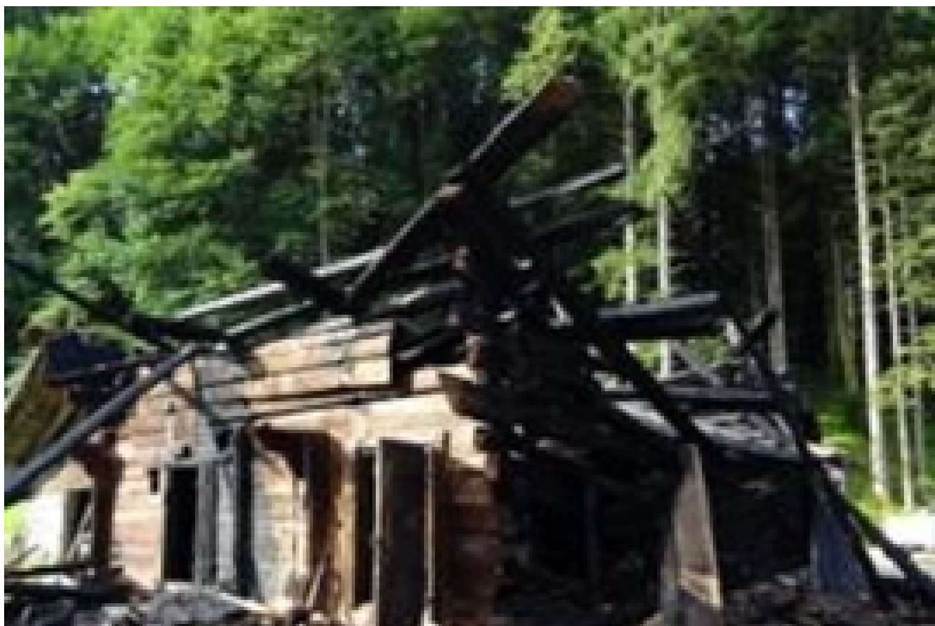
Scheune in Schattenhalb BE niedergebrannt
